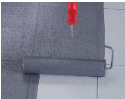
Aplikácia Eco Prim Grip Plus s valčekom na pôvodné obkladové prvky z porcelánu
