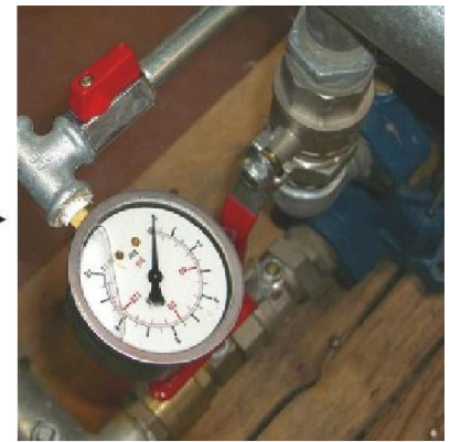
Obr. 6: Výmena TS za manometer
