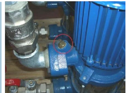
Obr. 7: Montáž snímača na odvzdušňovací otvor čerpadla
