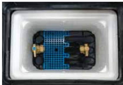
Montáž vodoměru stavební délky 165–190 mm
